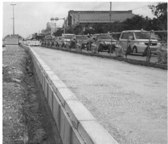
平成27年度 西崎地区舗装工事(施工中)
